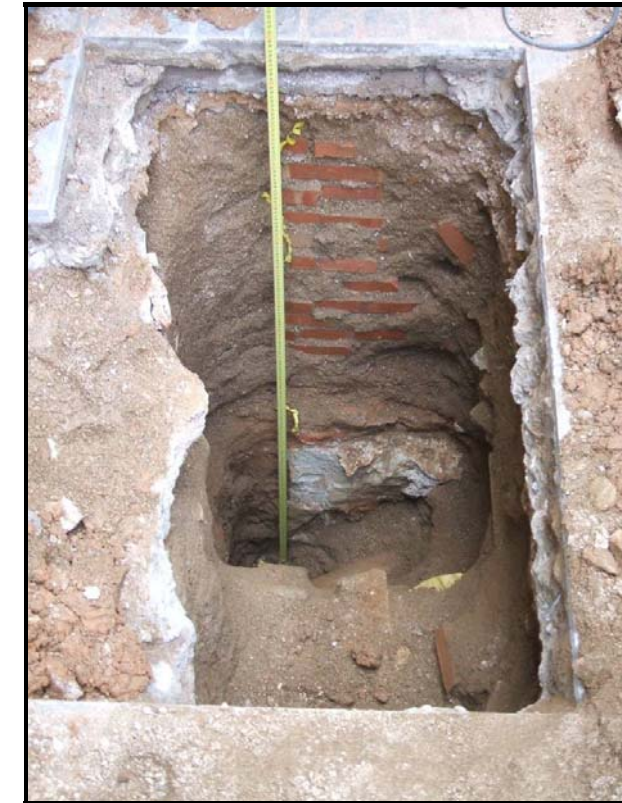
Fotografia 8: Paret de l'arqueta a sobre del mur.
