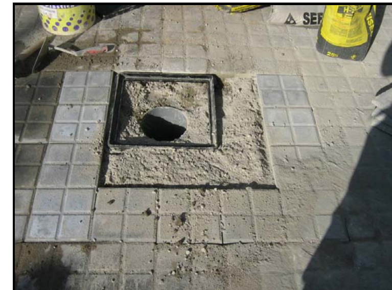
Fotografia 6: Tub col·locat per al sondeig.
