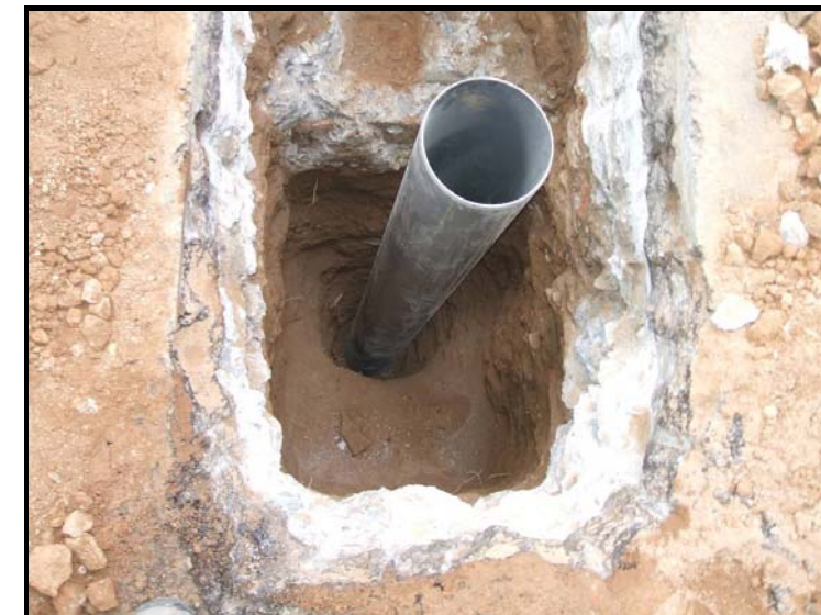
Fotografia 12: Col·locació del tub.
