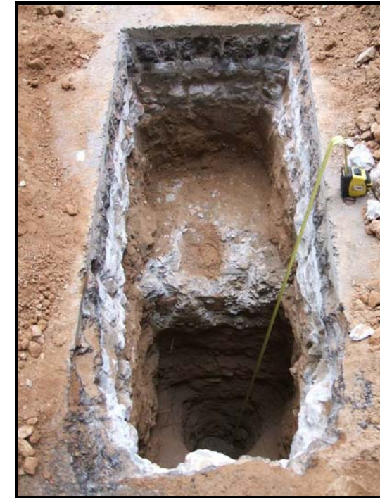
Fotografia 11: La cala de carrer de Fontanella, 12b amb el forat per al tub.
