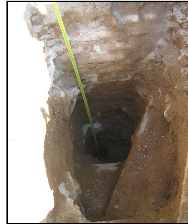
Fotografia 5: Volta de la claveguera i forat entre serveis on es va col·locar el tub; segona cala a Plaça Catalunya amb Portal de l'Àngel.
