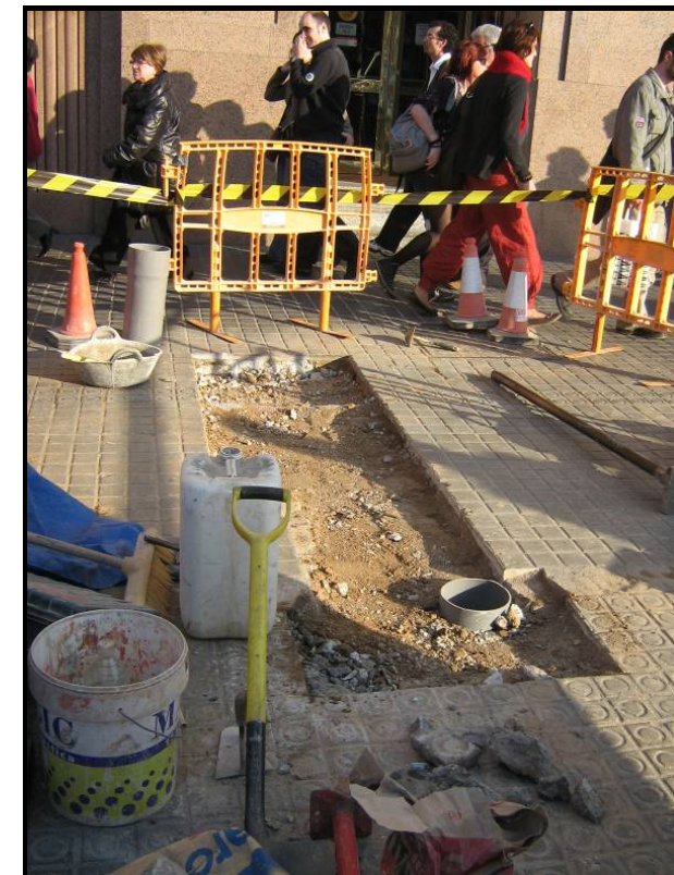
Fotografia 3: Tub col·locat a la cala i reomplerta de sauló.
