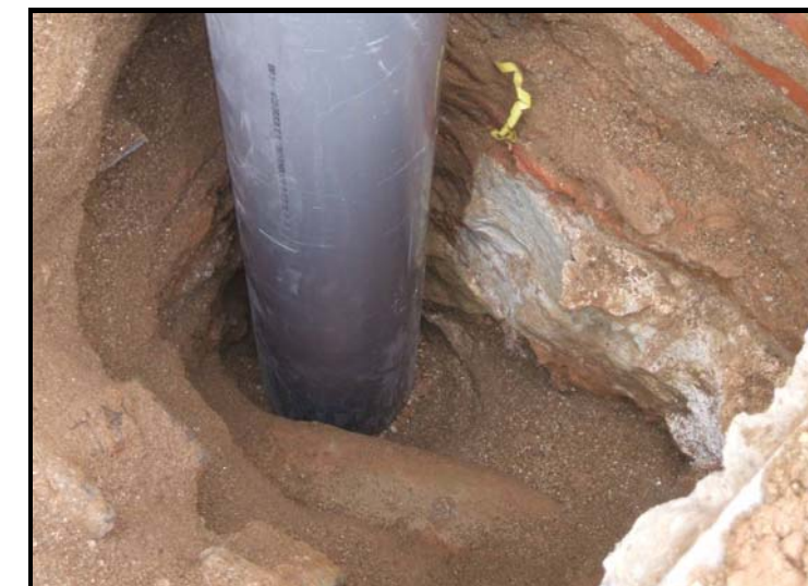
Fotografia 9: Tub posat entre el mur i canonada d'aigua.
