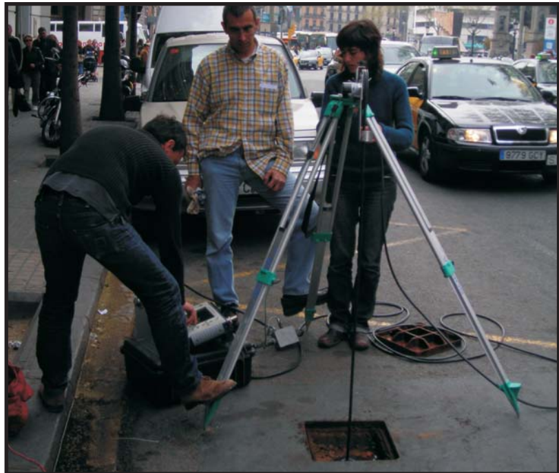
Prospecció amb radar de pou (Borehole) al carrer Fontanella.
